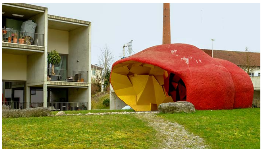
Extraordinaire – eine leuchtend rote Grotte mitten in einer Wohnsiedlung schützt eine kostbare Wasserquelle.
